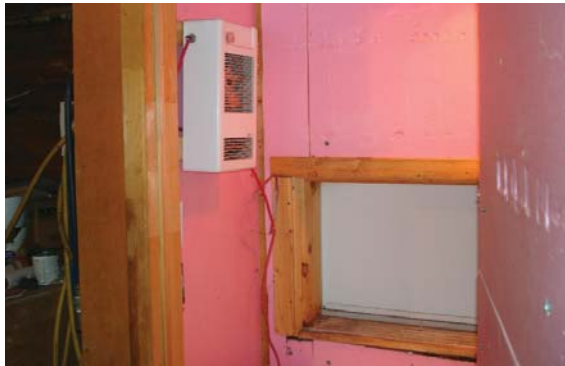
Livraison par portail dans portique isolé et chauffé (chaufferette). Les employés récupèrent la semence par l'intérieur, donc ne circulent pas dans les traces du livreur.
