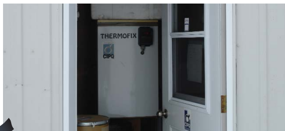
Réception dans thermofix et contenant pour le transport vers la ferme.
