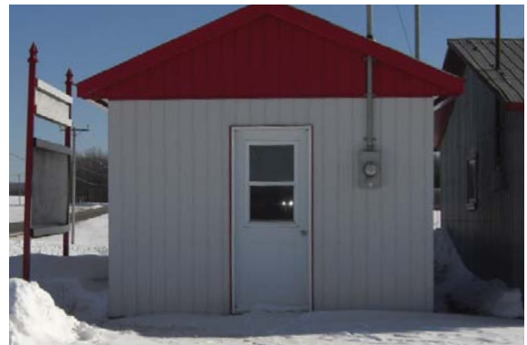
Réception dans la salle de génératrice près de la route.
