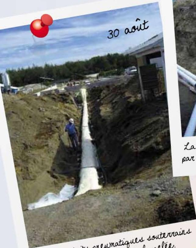
Les conduits pneumatiques souterrains sont bien protégés de la gelée.
